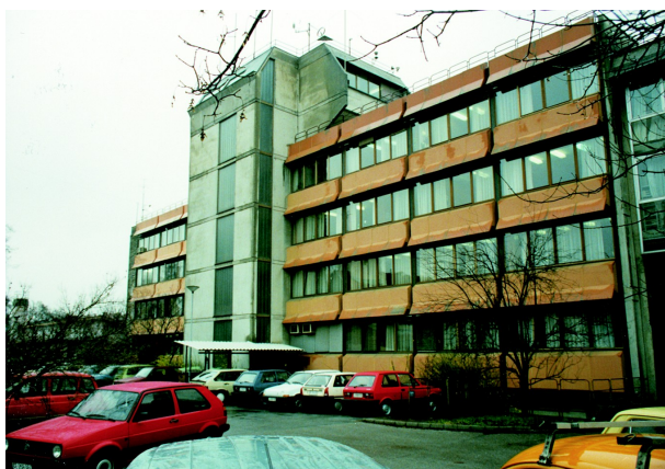
Slika 14. Zgradba Hidrometeorološkega zavoda in Zveze vodnih skupnosti po prihodu hidrologov z dvoriščne strani
