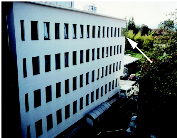
Slika 28. Nov prizidek, kamor se je preselila prognoza. Puščica kaže nove sobe za prognozo vremena.
